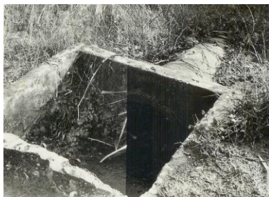
Foto n.º37 – Presa
