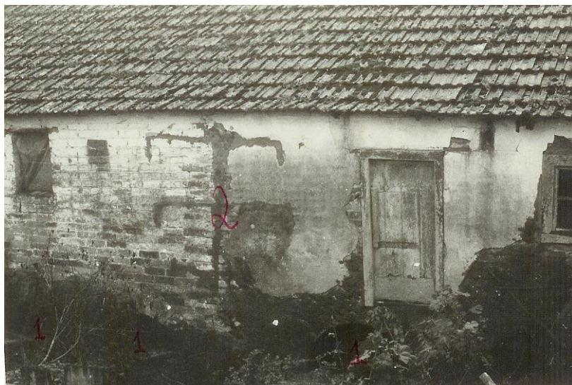
Foto n.º7 – Vista de frente (1) – entrada dos caboucos (2) – salas de moagem
